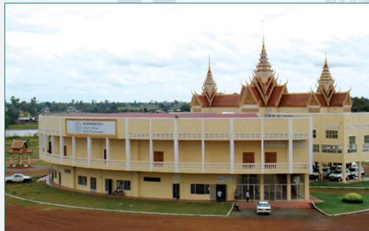
Le bâtiment qui accueille les Chambres extraordinaires.
